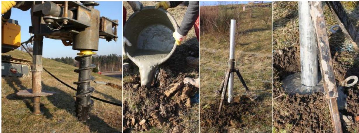
**Bild 7:** Herstellung eines Betonpfahls (Mustergründung) auf einer Deponieböschung (Böschungneigung 1:2,5)
