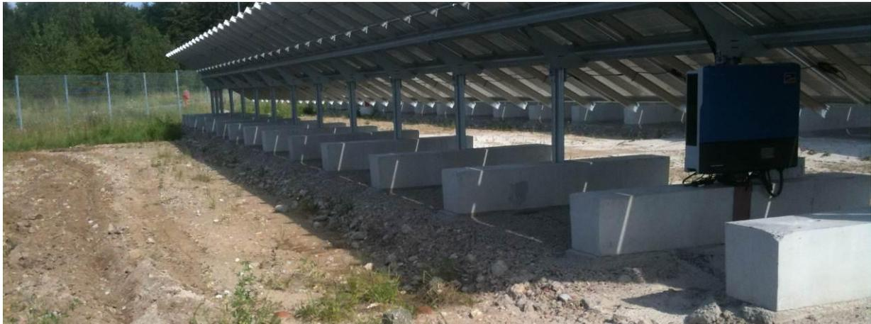
**Bild 4:** Auf die Oberfläche aufgesetzte Streifenfundamente; Ausgleichssicht wurde aus Mineralgemisch hergestellt (Fotovoltaikfreiflächenanlage in Zeitz 2011 errichtet)
