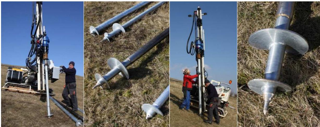
**Bild 6:** Einbau verschiedener Drehfundamente (Mustergründung) auf der Südböschung (Böschungneigung 1:2,5) der Altdeponie Gröbern in Niederau
