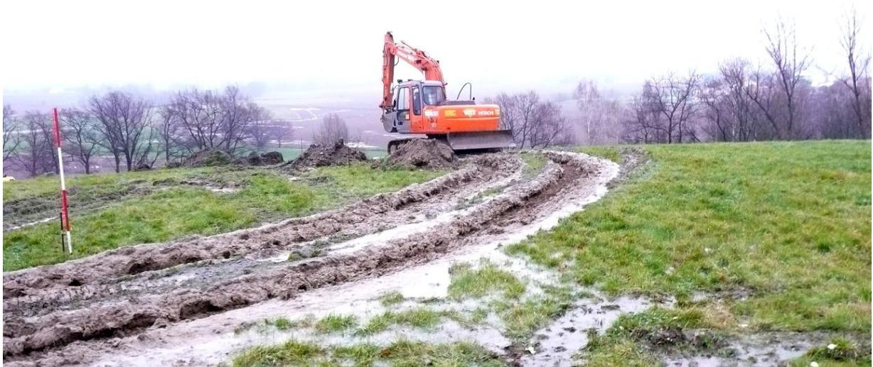
**Bild 5:** Schädigung der erosionsstabilen Vegetationsdecke und des Rekultivierungsbodens einer Deponie durch schwere Baumaschinen bei ungünstiger Witterungslage
