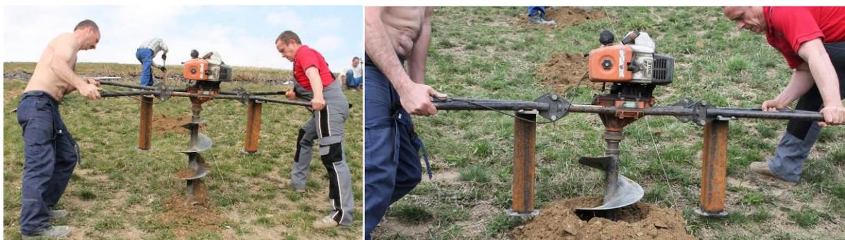
**Bild 10:** Herstellung der Fundamentlöcher mit einem Handbohrgerät und installiertem Maschinenanschlag
