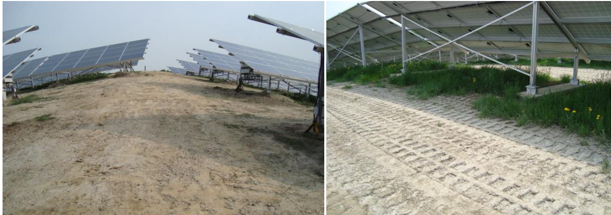
Abb. 1: Zustand der Deponiefläche nach der Installation der Solarpaneele
